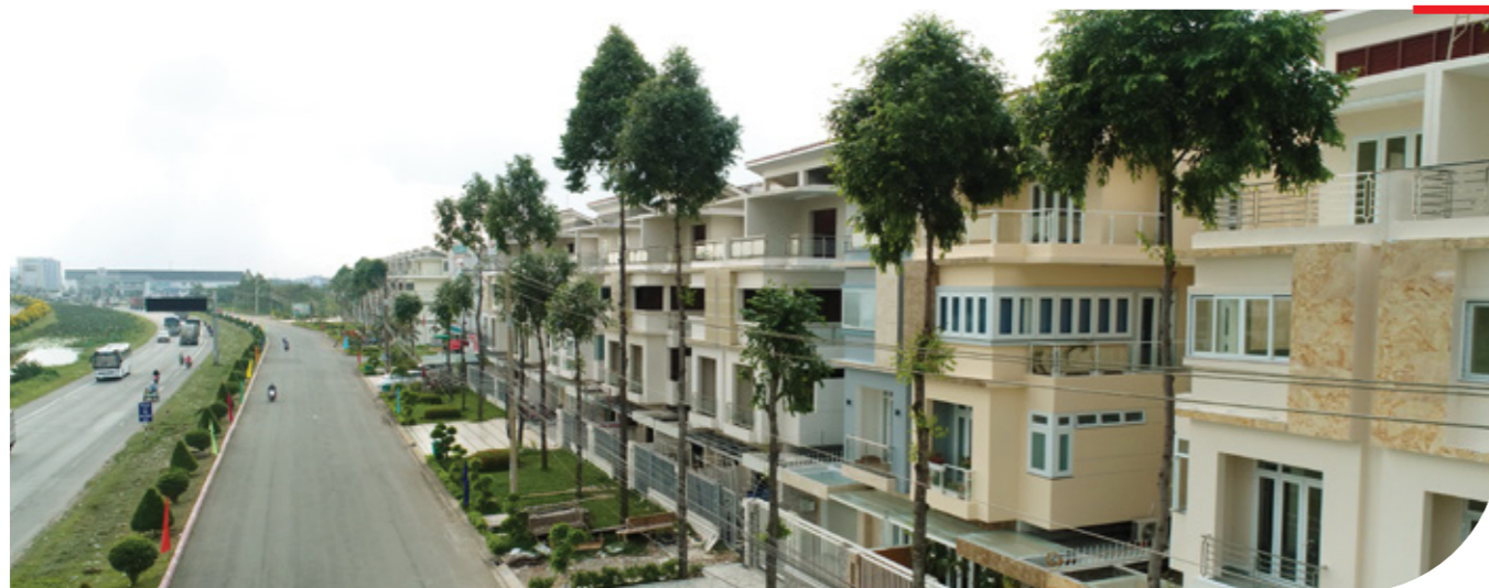
Khu nhà liên kế tại Khu đô thị Trung tâm Hành chính tỉnh Long An - Green City
