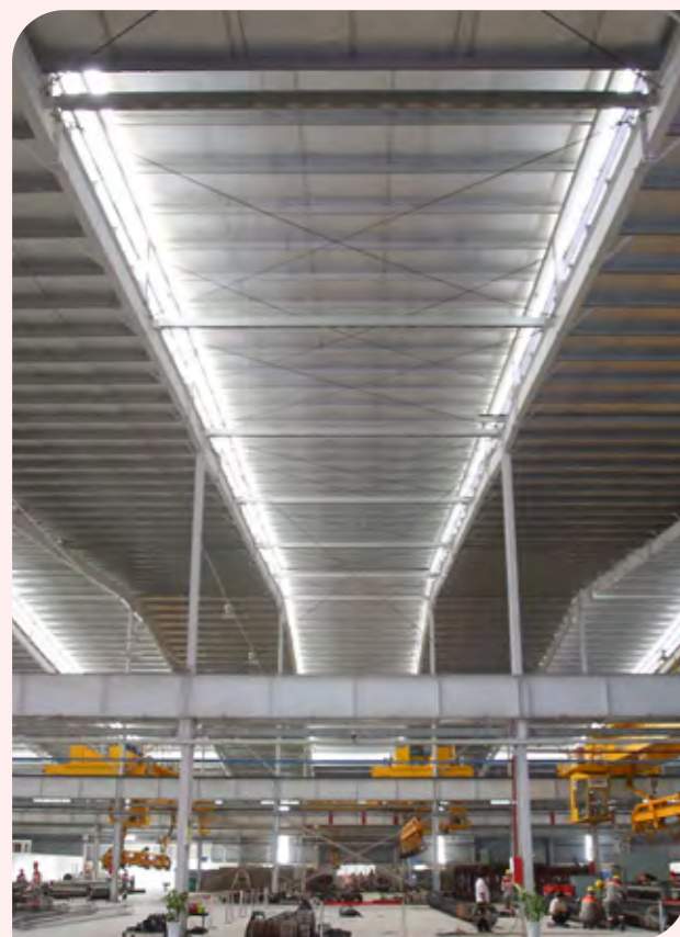
Nhà máy sản xuất cộc bê tông dự ứng lực Đồng Tâm tại Bến Lức, Long An với công suất sản xuất 1.000.000 m 3 /năm
