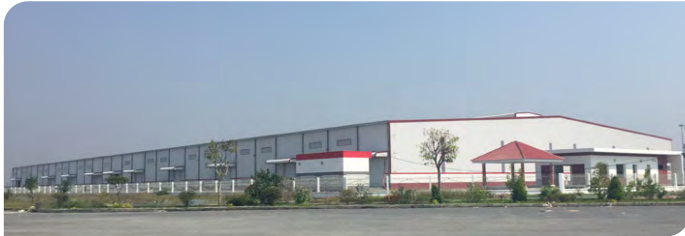
Hệ thống nhà kho logistics tại Cảng Quốc tế Long An
