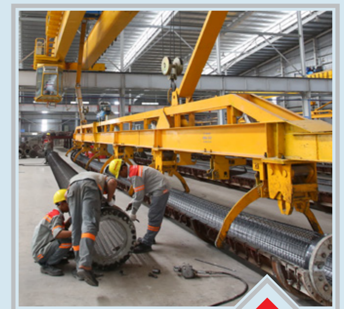
Dây chuyền sản xuất cọc bê tông ly tâm dự ứng lực.
