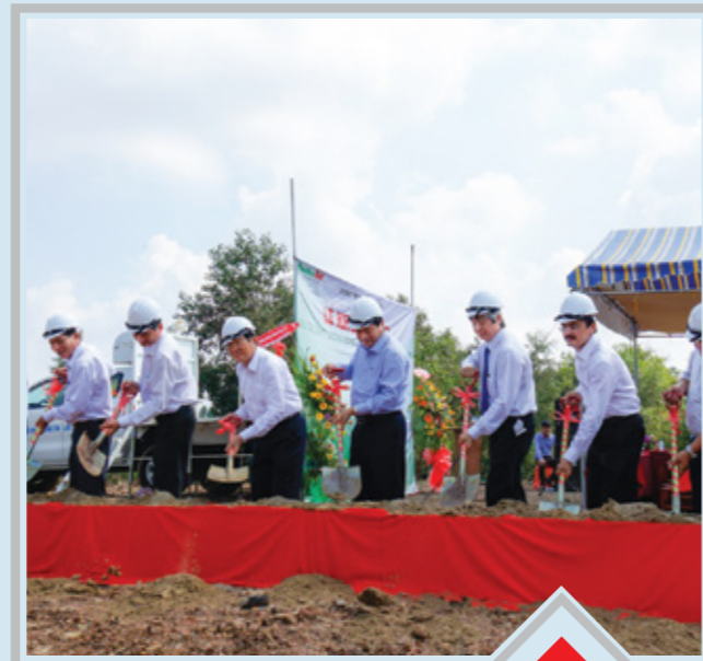
Khởi công xây dựng cầu nông thôn tại các huyện vùng sâu, vùng xa tỉnh Long An
