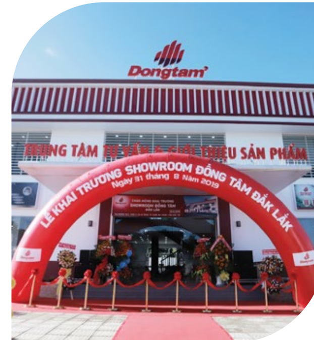
Trung tâm phân phối, tư vấn và giới thiệu sản phẩm (showroom) tại Tp. Buôn Ma Thuột, tỉnh Đắk Lắk được chính thức khai trương vào tháng 8/2019, trở thành showroom lớn nhất tại khu vực Nam Trung Bộ và Tây Nguyên.
